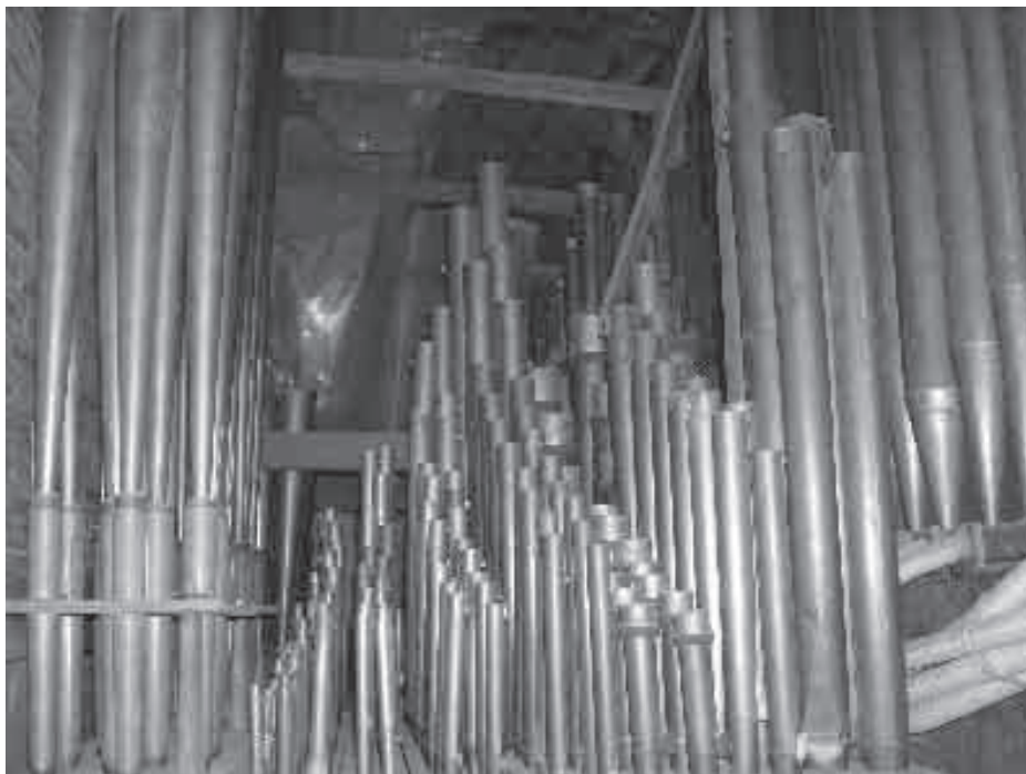
Lám. nº 20.- Tubería interna del órgano de la restauración realizada en 1970 por Organería Española S.A. AMP, 2009.
