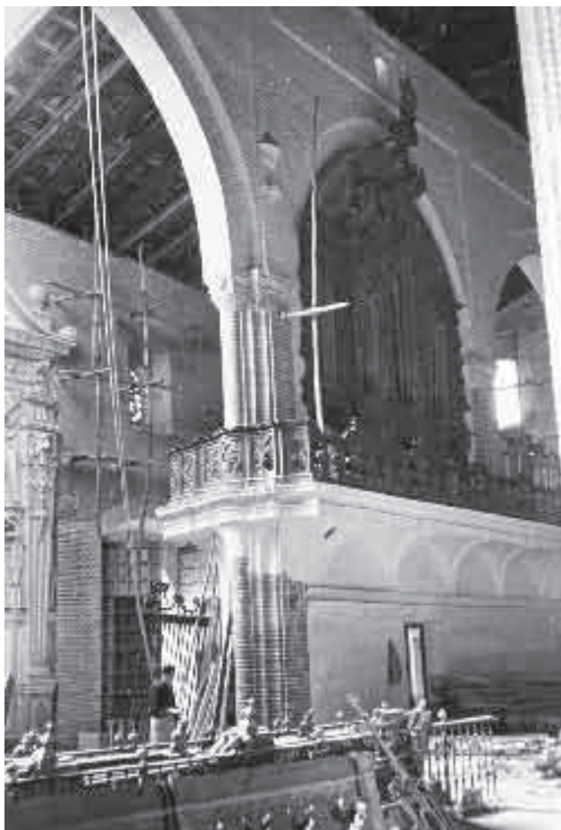
Lám. nº 4.- Trabajos de desmantelamiento del coro, se puede apreciar la antigua ubicación del órgano.
