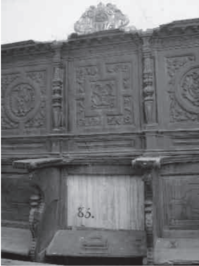
Lám. nº 13. Estado de deterioro que presenta la sillería. AMP.
