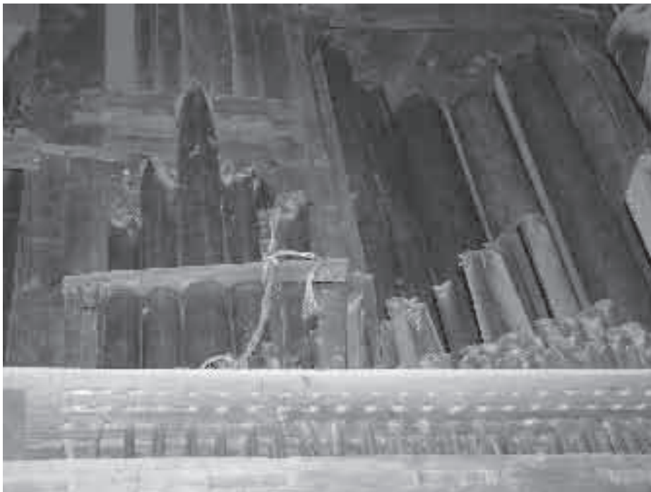
Lám. nº 20. Interior de la caja del órgano donde se aprecian la tubería deformada y desaparecida en parte. AMP.
