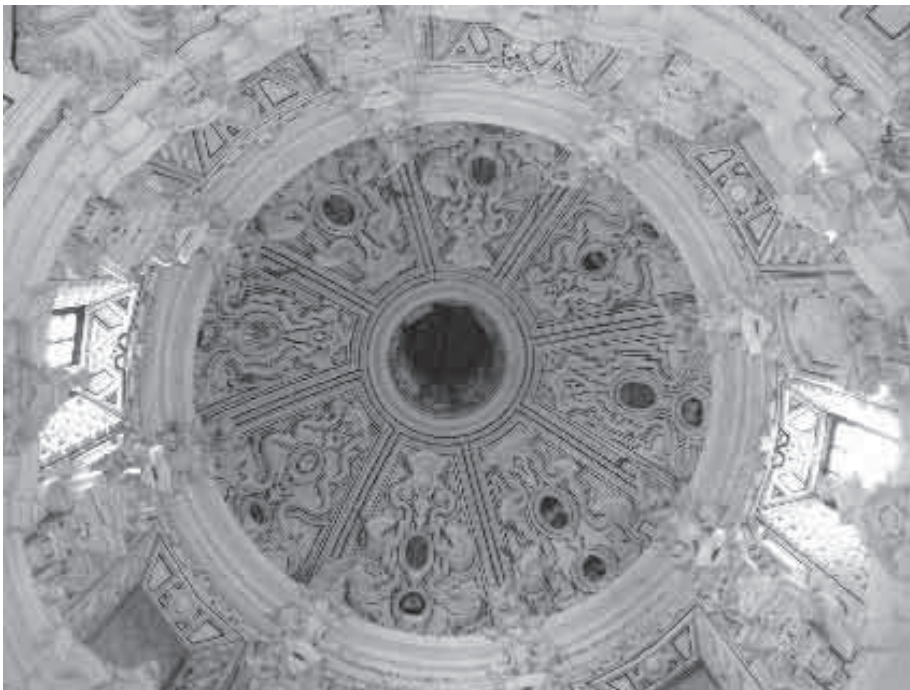
Lám. nº 10. Camarín. Vista interior de la cúpula. Obra anónima. Hacia 1739.
